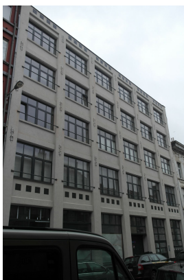
Gheudestraat 15-19, bijgebouw van de voormalige chocoladefabriek Ruelle van 1906-1913 vermoedelijk n.o.v. architect J. Rosschaerts, 2015
