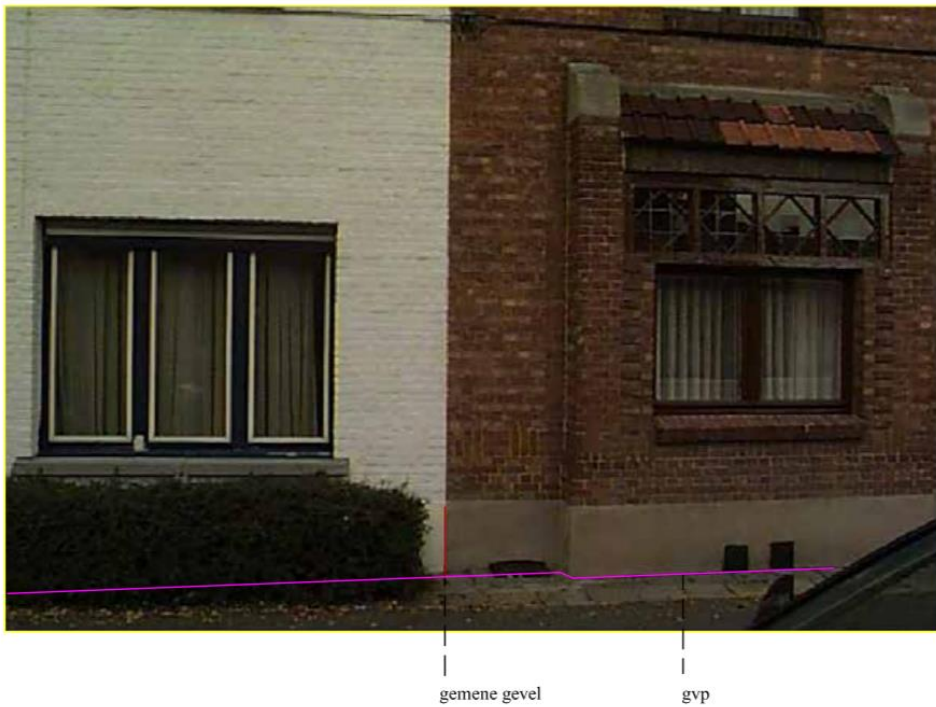
Figuur 8: Deze figuur toont een gematerialiseerde as (kleurverschil), ter hoogte van de zwarte stippellijn (gemene gevel)).
