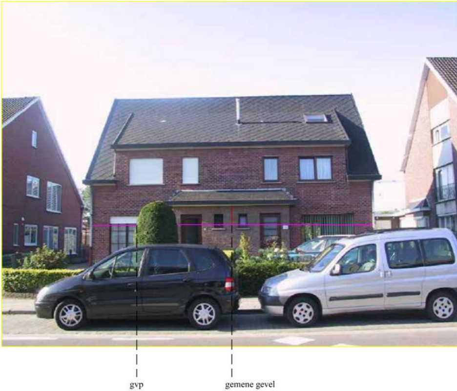
Figuur 7: Deze figuur toont een niet-gematerialiseerde as, ter hoogte van de zwarte stippellijn (gemene gevel), die de constructie opdeelt in twee gespiegelde delen. Deze as komt vermoedelijk overeen met een interne opdeling van het gebouw.
