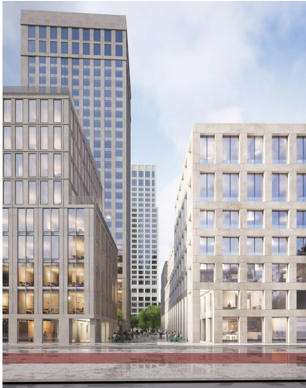
Immo Cordeel – Aertssen NV nieuwbouw Pelikaansite
