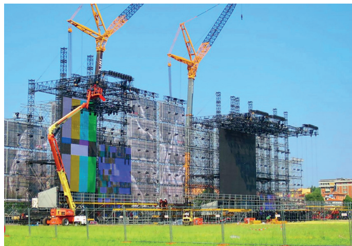
Podiumbouw Vasco Rossi, Italië door Stageco Belgium
