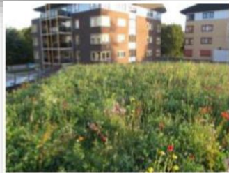
Groendak met sedum, grassen en kruiden
