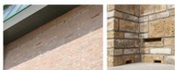
Rechtlijn voor dakvlakken (2) zie Inbouw- en opbouwvariant. Over de schouwen. Afbeelding: Inbouw-variant (links) en opbouwvariant (rechts) voor dakvlakken.
