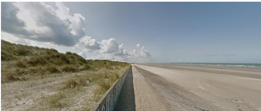
Figuur 7-101: Zicht op de duinvoetversteving ter hoogte van de Westhoekduinen
