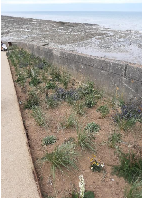
Foto 7-1: Plantvakken t.h.v. boulevard in Ault (Frankrijk)
