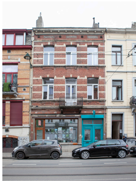
Gevel Werkplaats Walter © Anton Coene
