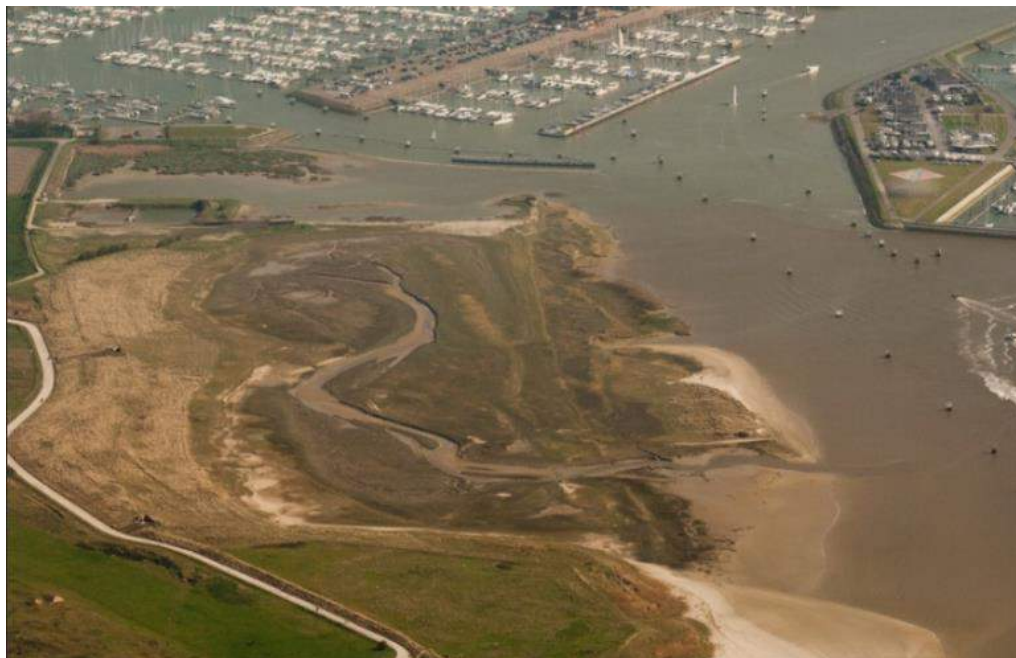
Fig. 6.4.1.3.1.4 (a) IJzermonding (aerial view)
