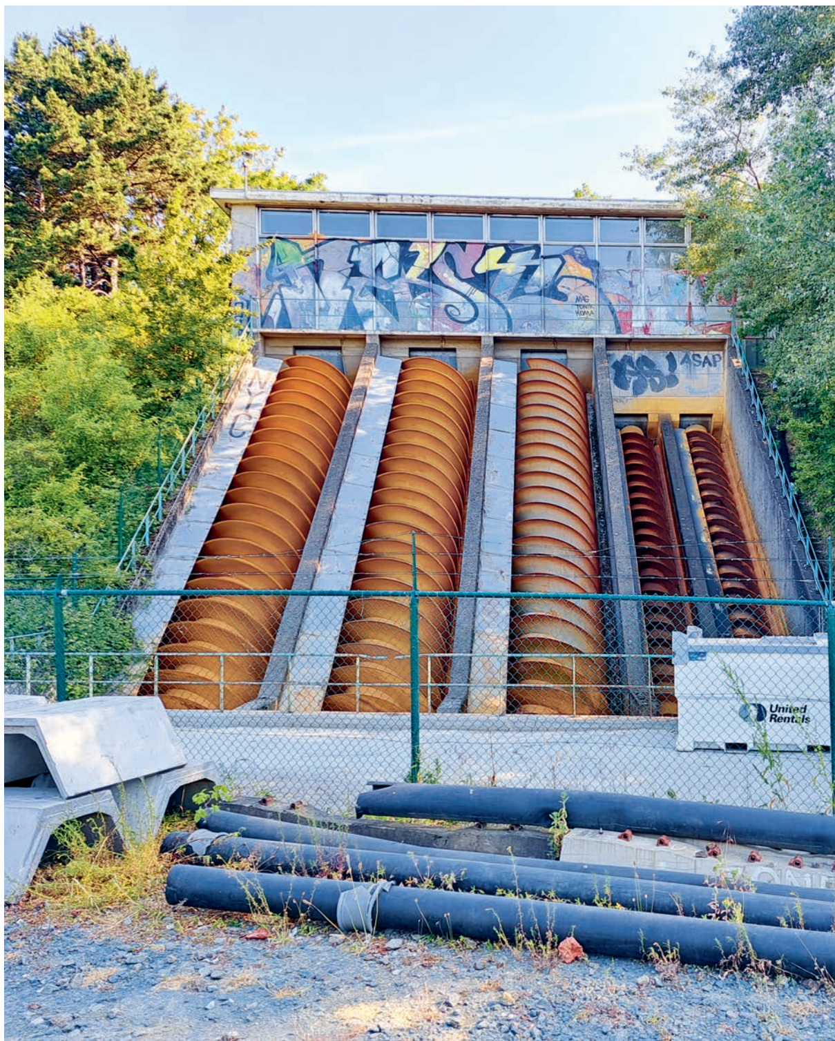
Het pompgemaal aan de Desguinlei zorgt ervoor dat de Antwerpse Ring, die een stuk dieper ligt dan de omgeving, droog blijft. © Stad Antwerpen
