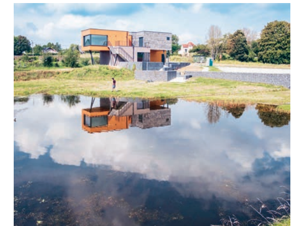
Het bufferbekken op het bedrijventerrein Keiberg-Vosseem vangt het regenwater collectief op. Na zuivering wordt het hergebruikt door de omliggende bedrijven. © Bob Van Mol
