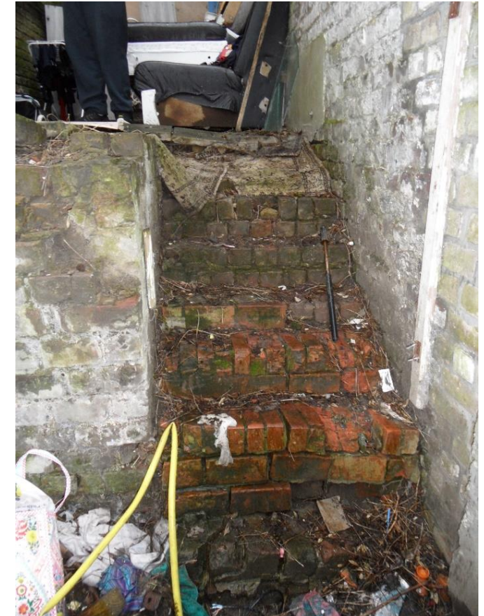
Verweerde trap en handgreep ontbreekt
