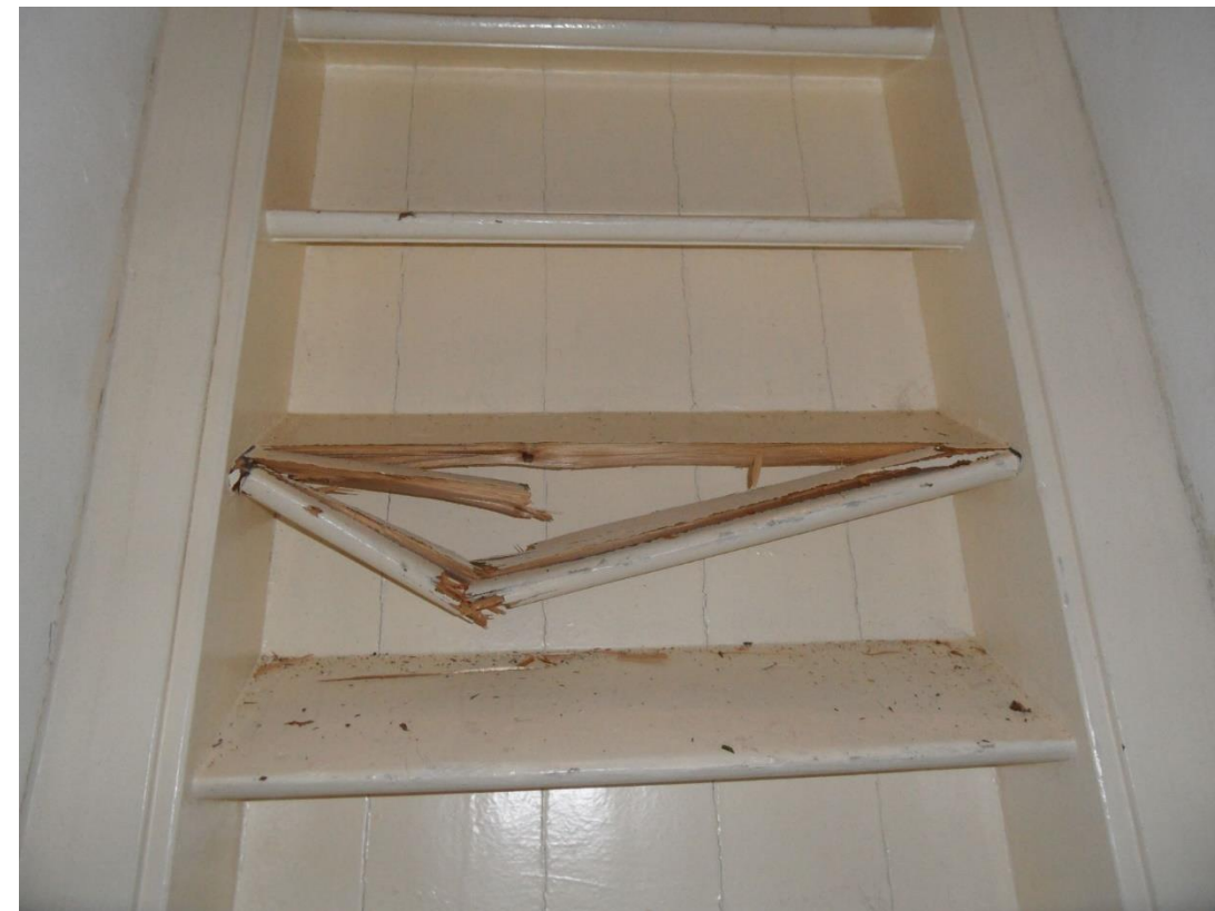
Trede beschadigd en steile trap
