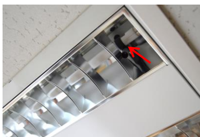
Figuur 92: Daglichtsensor op TL-verlichting in een armatuur
