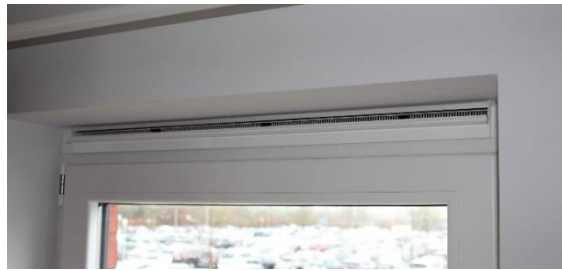
Figuur 47: Regelbare toevoeroening geïntegreerd in raamprofiel
