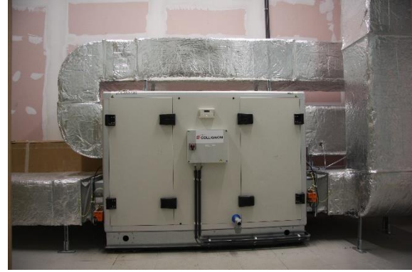
Figuur 45: voorbeelden van mechanische toevoer- en afvoerventilatorgroep
