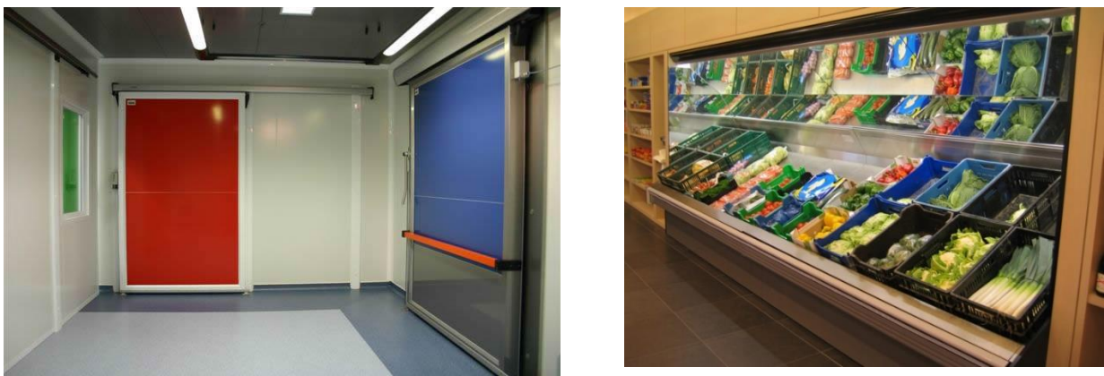
Figuur 55: Voorbeelden van proceskoeling: koelcel (links) en koeltoonbank (rechts).
