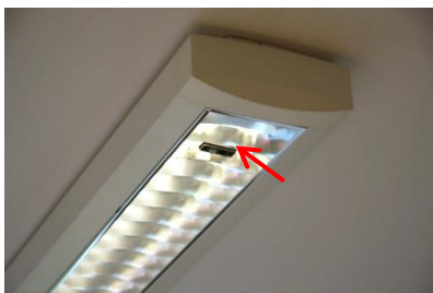
Figuur 89: Daglichtsensor en sensor voor aanwezigheidsdetectie ingebouwd in een armatuur
