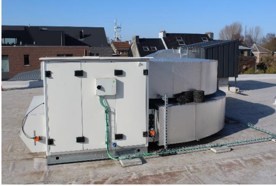
Figuur 45: voorbeelden van mechanische toevoer- en afvoerventilatorgroep
