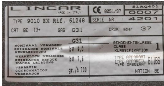
Figuur 32: Voorbeeld van een kenplaat waarop het type toestel vermeld staat (hier B11BS)
