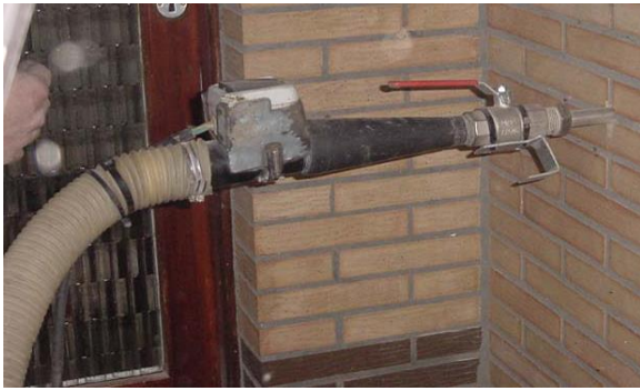
Figuur 100: Plaatsen van na-isolatie
