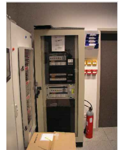
③ Hoofdbrandcentrale Centrale de détection principale
