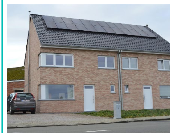
Nieuwbouw: Halfopen bebouwing
