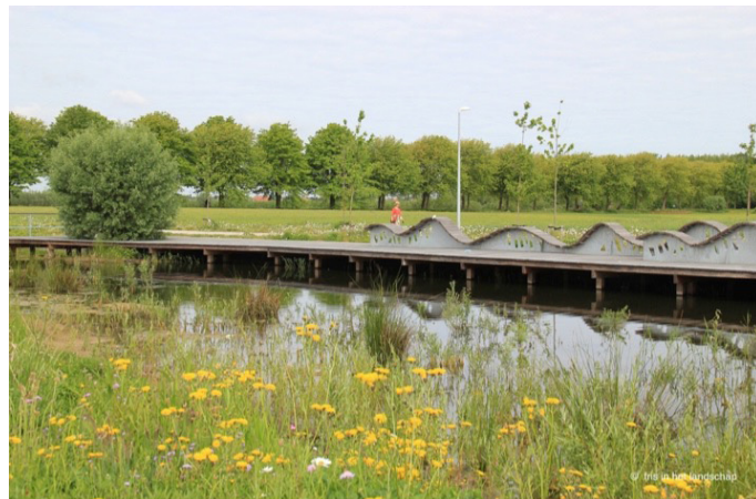
Water werd de basislayer voor het ontwerp van een duurzame Clementwijk2, bestaande grachten werden behouden en versterkt. Tusseliggende bolakkers werden als woonveld bestemd. Oevers met natuurlijke vegetatie
