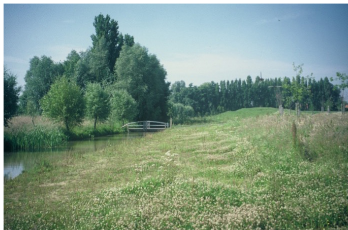
Groene Long Kuurne 1997: oever in zachte helling. Afgraving oever van -10 tot -80 cm. Situatie met pionniersvegetatie net na de aanleg
