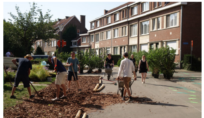
Aanleg van een proefopstelling voor een ontharde straat
