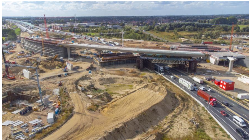
Figuur: Oosterweelverbinding werkzaamheden (© Liantis)
