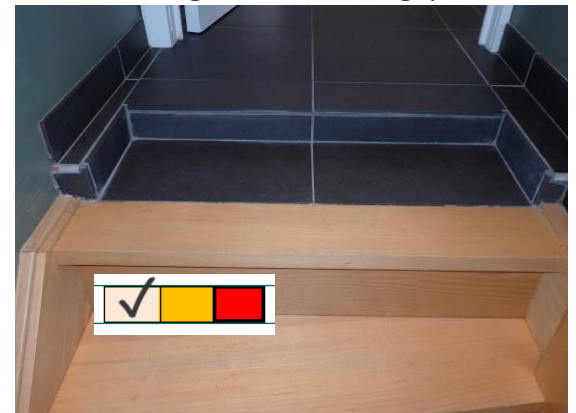
Vloer verhoogd en trede 'aangepast'
