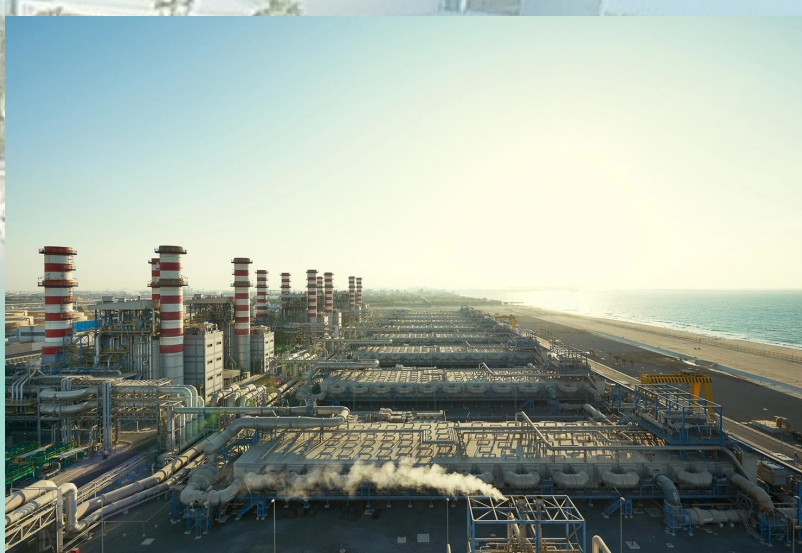
Desalination plant on Dubai's coast opgehaald van TIME
