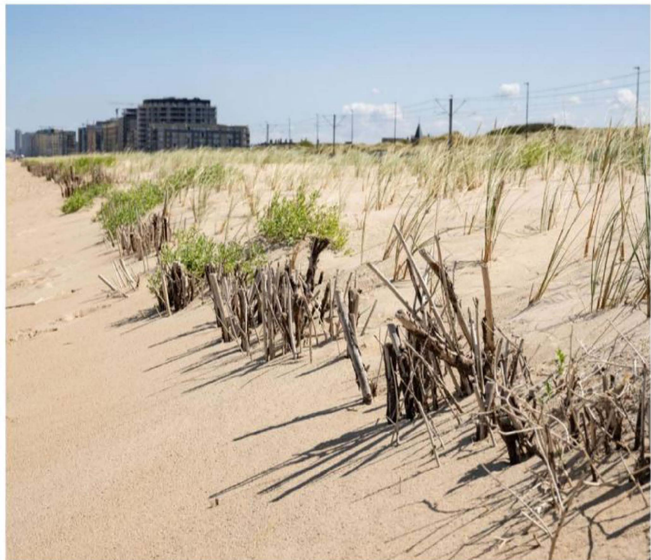
Op een stuk strand van 120 meter in Oostende werd begin 2021 helmgras geplant. 'Er komt jaarlijks vijftien kubieke meter zand bij, per strekkende meter, meer dan we verwacht hadden en het gaat
