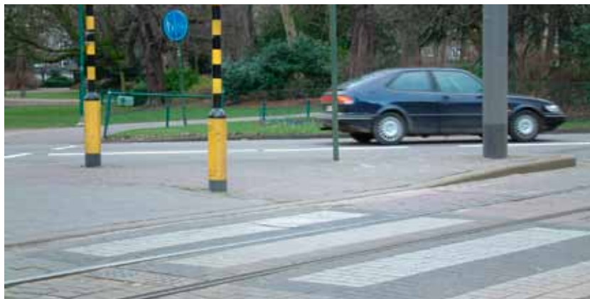
Oversteekvoorziening over tramsporen
