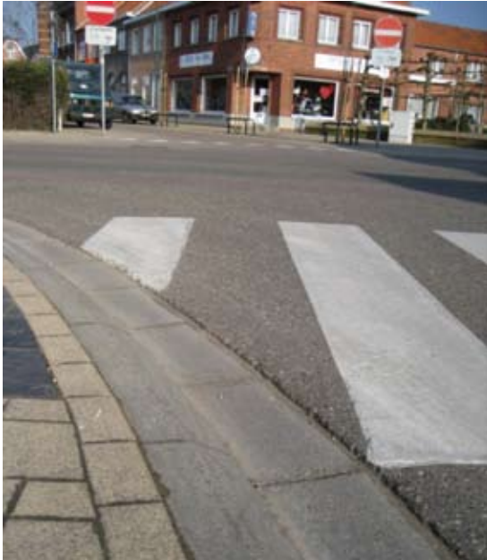
Fig. 2.1.4l Een overrijdbare trottoirband, bijvoorbeeld zoals hier type IE of type IF zijn ontworpen op maat van gemotoriseerde voertuigen. Zij voldoen niet als toegankelijke stoeprandverlaging t.b.v. rolstoelgebruikers.
