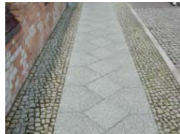
Fig. 2.1.3l De looproute en obstakelzone zijn in verschillende materialen uitgevoerd. Dit verschil in textuur kan ook goed dienen als natuurlijke geleiding.
