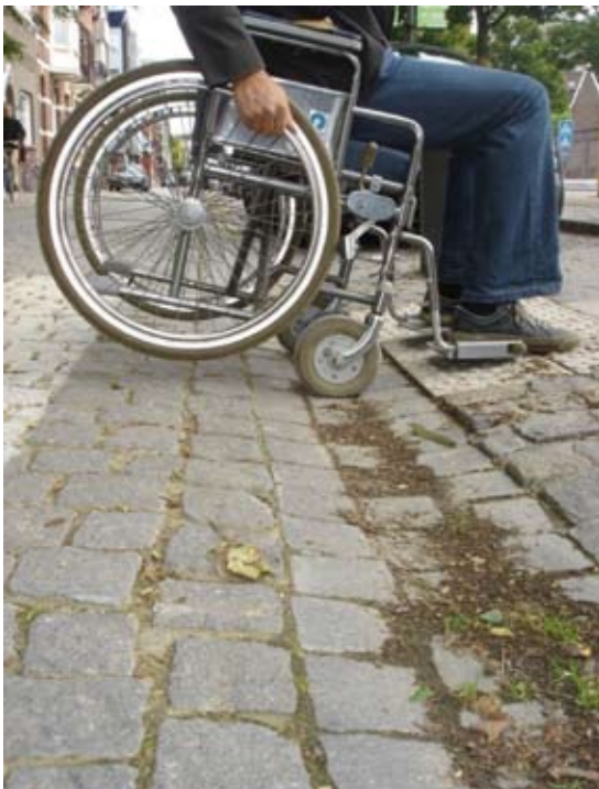
Fig. 2.1.4h Wanneer rolstoelgebruikers diepe en/of komvormige goten moeten dwarsen is het risico groot dat men met de voetsteun in aanraking komt met de grond, waardoor men kan kantelen
