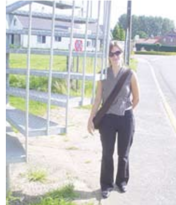
Fig. 2.1.1n Aan deze trap kan een blinde of slechtziende zich behoorlijk kwetsen, doordat het obstakel op grondniveau niet tastbaar is.
