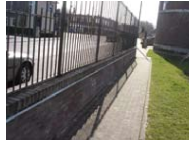
Fig. 2.1.3i De gevelwand is een goede natuurlijke gidslijn op voorwaarde dat er niet te veel (losse) obstakels de lijn verstoren.
