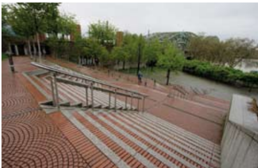
Fig 2.1.4y Bij deze lange trap heeft men tussenbordessen voorzien, waarop de traploper tussentijds kan uitrusten. De leuning had ten behoeve van blinde en slechtziende personen over de tussenbordessen door moeten lopen, zodat deze ook als geleiding zou kunnen dienen.
