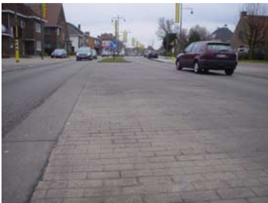
Fig. 3.1h Plaatsen die niet intensief gebruikt worden zijn gevoelig voor onkruid. Met deze wetenschap kan men maar beter materialen gebruiken die minder of niet gevoelig zijn voor onkruid, zoals printbeton voor een middenberm.
