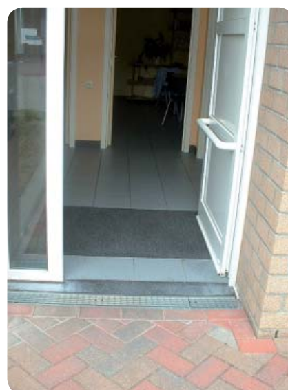
Exemple de seuil contribuant directement à l'étanchéité à l'eau et à l'air de l'ensemble menuisé associé à une ouverture télécommandée.
