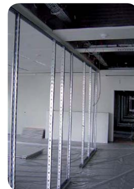
Fig. 1 - Ossature d'une cloison démontable.
