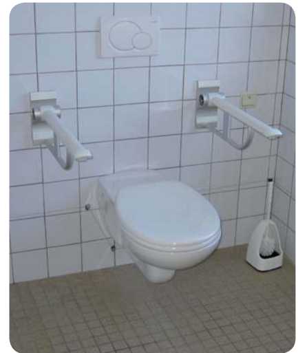
Placement de barres d'appui dans W.-C. adapté.
