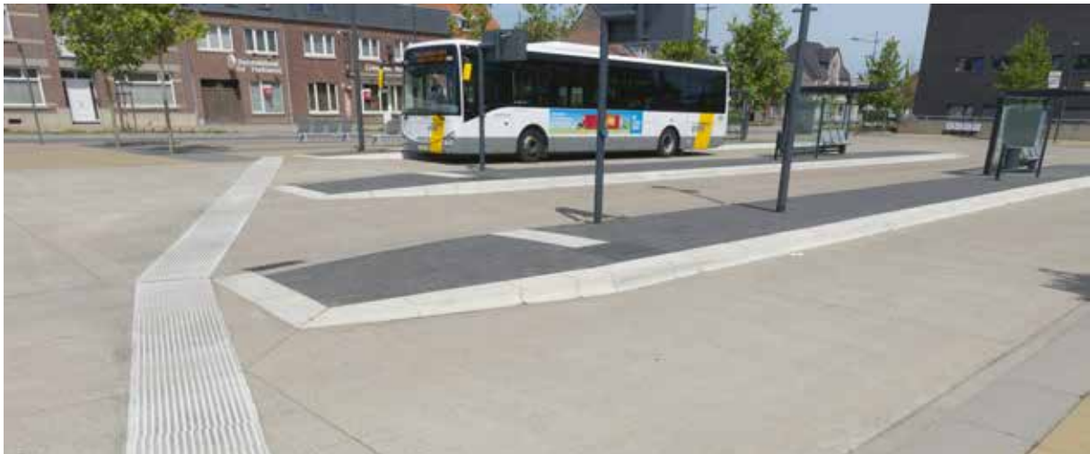
Busstation Riemst: een perron bereikbaar met hellend vlak.
