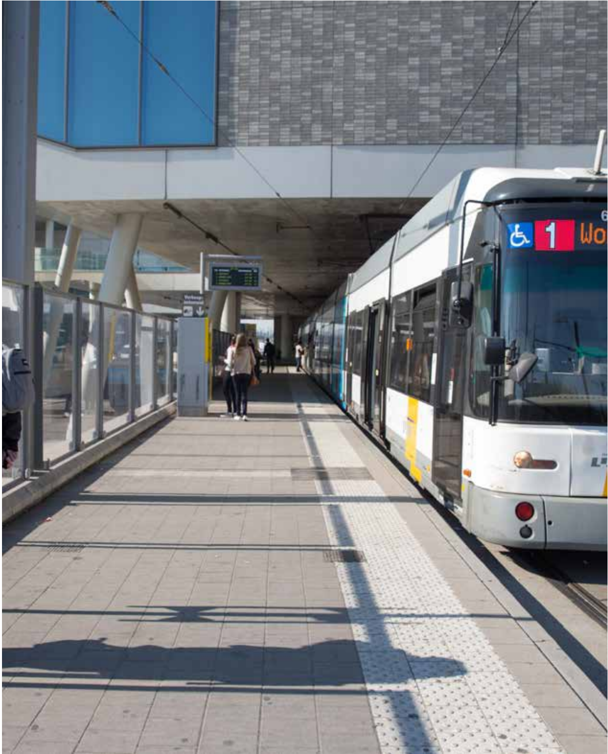
tot aan de natuurlijke gidslijn. Tramhalte met veiligheidsstrook in noppentegels over de volledige lengte van het perron.
