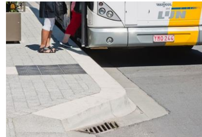
Figuur 6: Een toegankelijke bushalte heeft een aanrijdbare boordsteen en tactiele geleiding
