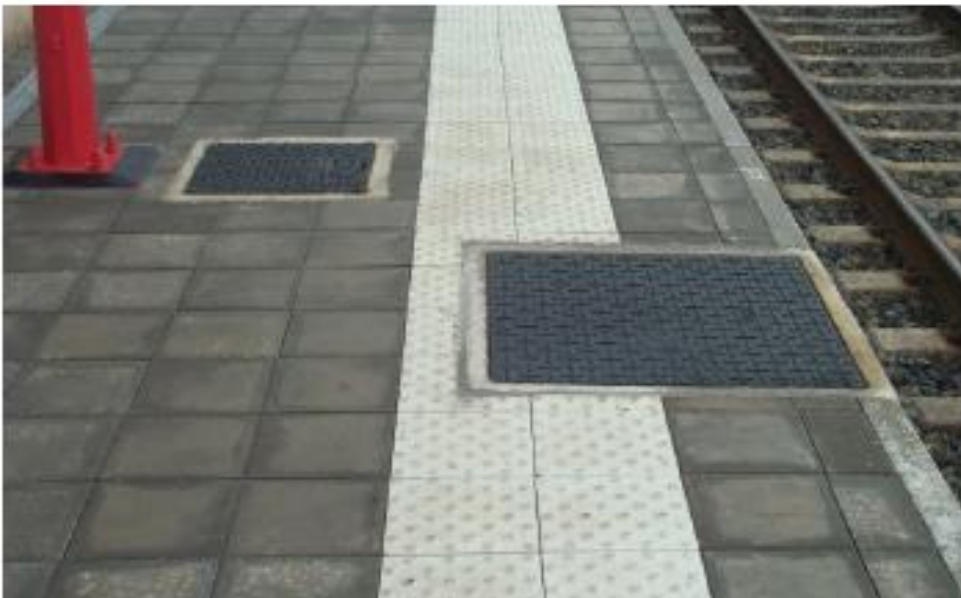
Onderbreking van de tactiele bevoering (niet conform)
