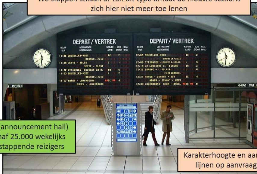
Brussel Luxemburg: 2 AH panelen, 10 lijnen, 50 mm karakterhoogte
