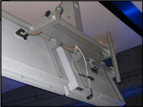
Kabeldoorvoer correct
