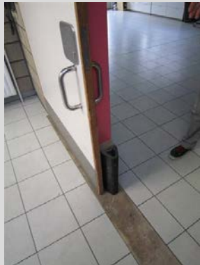
Beschadiging van een raamkader - Beperkte voeg in vloerbetegeling – Overgang verschillende vloerafwerking. St. Lodewijk vzw, © Enter vzw
