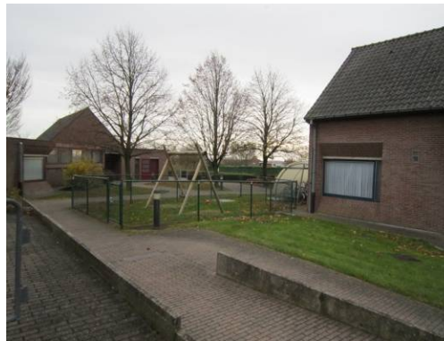
Paden zijn drempelloos, niveauverschillen correct overbrugd. Zorgcentrum Maria - Ter - Engelen vzw, © Enter vzw
