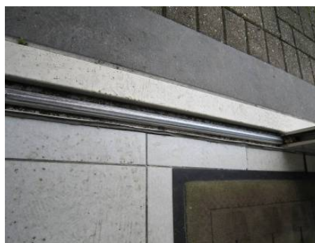
Het kleinste niveauverschil bij een overgang tussen binnen buiten zorgt voor een drempel (rolstoelgebruik). St Lodewijk vzw, © Enter vzw
