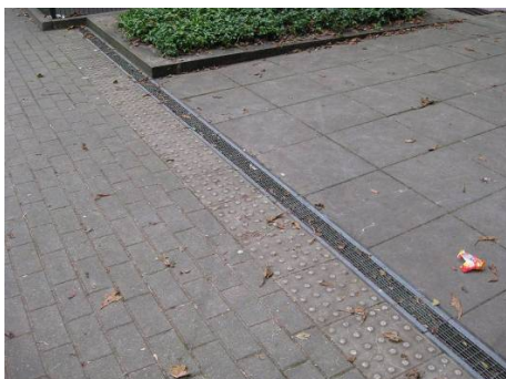
Rooster langs en dwars op de circulatierichting. Langs het rooster is routegeleiding aangelegd naar de toegangsdeur. Koninklijk Instituut Woluwe, ©Enter vzw
