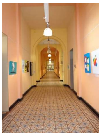
Gang met op regelmatige afstand een verlichtingsarmatuur, dit zorgt voor een egale verlichting over de volledige gang. Koninklijk Instituut Woluwe, ©Enter vzw
