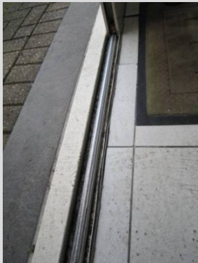
Beschadiging van een raamkader - Beperkte voeg in vloerbetegeling – Overgang verschillende vloerafwerking. St. Lodewijk vzw, © Enter vzw
