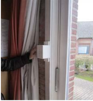
Voorbeeld van beveiliging van rolluikdrukknop in een houten kastje. Zorgcentrum Maria - Ter - Engelen vzw, © Enter vzw
