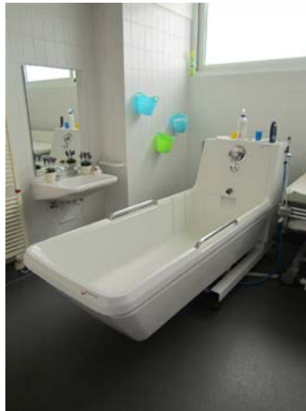
Hoog- laag bad Zorgcentrum Maria - Ter - Engelen vzw, © Enter vzw
