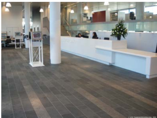
Een onthaalbalie met 2 hoogtes, beperkt onderrijdbaar. Stadskantoor Leuven, © Enter vzw
