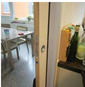
Schuifdeur met een ingewerkte greep die zeer moeilijk te gebruiken is! Zorgcentrum Maria - Ter - Engelen vzw, © Enter vzw
