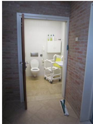
Kantel schuifdeur naar het aangepast toilet.
