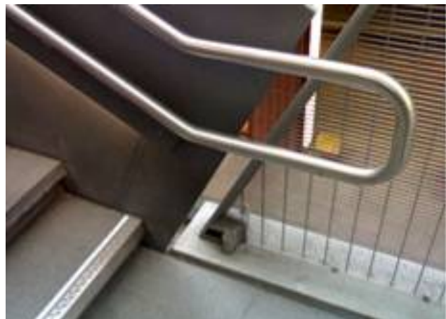
Leuning die doorloopt na het einde van de trap en afgerond is. Station Antwerpen centraal, © Westkans vzw
