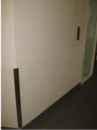
Bescherming van de hoeken d.m.v. inox hoekprofiel en van de wanden d.m.v. cementering en een afwerking met tusk (wandafwerking op basis van geslepen glasdeeltjes). Sint - Gerardus Diepenbeek, © Enter vzw Toegankelijkheidsbureau vzw
