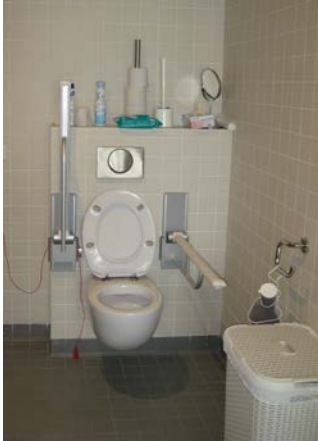
Hangtoilet met in hoogte verstelbare en opklapbare beugels.
