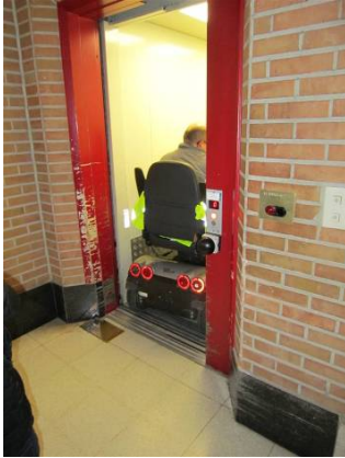
Lift type 2, basis rolstoeltoegankelijke lift. Dominiek Savio Instituut, © Enter vzw
