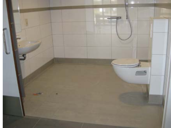
Ruime sanitaire cel met opstelruimte voor een douchebrancard op de vlakke douchezone. 't Weyerke, © Toegankelijkheidsbureau vzw
