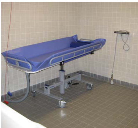
Verrijdbare douchebrancard, ook bruikbaar als verzorgingstafel. De kraan staat op een goed bereikbare plaats (douchekophouder is niet aanwezig). Sint - Gerardus, ©Toegankelijkheidsbureau
