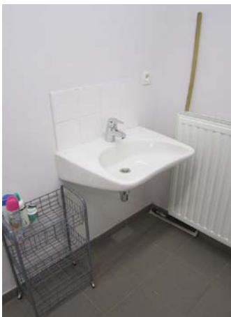
Wastafelmodel met afgeronde voorzijde, ergonomisch model. Hierdoor is de kraan en de waterstraal gemakkelijker bereikbaar KiDs vzw, © Enter vzw
