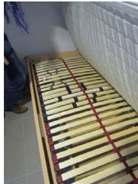
Elk bed is uitgerust met een trilsysteem dat aangesloten is op het brandalarm. KiDs vzw, © Enter vzw
