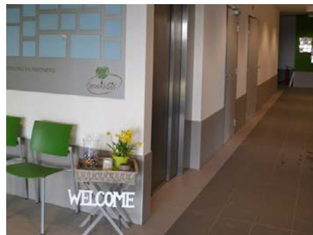
Bescherming van de hoeken en de wanden d.m.v. betegeling. Groenhoef, Stijn vzw, © Toegankelijkheidsbureau vzw
