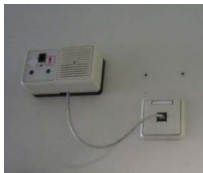
Een auditief alarm in de kamers van jongeren met een verstandelijke beperking. Op deze manier kan er 's nachts bij een oproep contact gelegd worden. Niet iedere gast heeft dit nodig. De aansluiting voor het systeem is wel in elk kamer aanwezig. Zorgcentrum Maria - Ter - Engelen vzw, © Enter vzw
