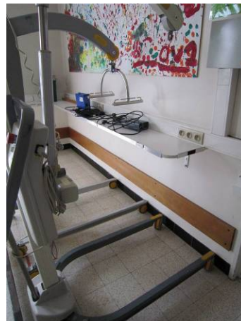
Laadpunt met meerdere stopcontacten per plaats.
