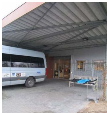
Overdekte voorrijdzone. Er is een wachtzone aanwezig voor wie toekomt of vertrek. Stijn vzw, © Enter vzw
