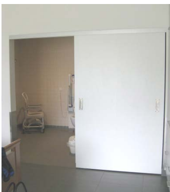
In open stand is de badkamer vlot toegankelijk en wordt de inkomhal afgesloten om de privacy te verzekeren. De schuifdeur heeft aan twee zijden een ingebouwde greep. Er kan een opbouwgreep worden geplaatst als de bewoner dat wenst.
