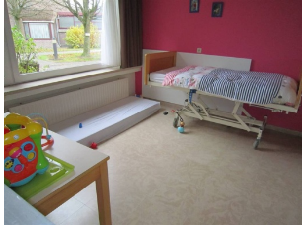
Lage borstweringshoogte aan een kamerraam. Zorgcentrum Maria - Ter - Engelen vzw, © Enter vzw
