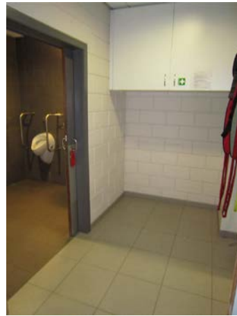
Tussenas tussen 2 ruimten doet dienst als extra transferruimte: hier blijft de rolstoel staan als er een verrijdbare tillift gebruikt wordt. Mané vzw, © Enter vzw
