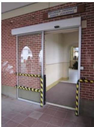
Bescherming van de glazen deur: ijzeren kader met waarschuwingsmarkering. St. Lodewijk vzw, © Enter vzw
