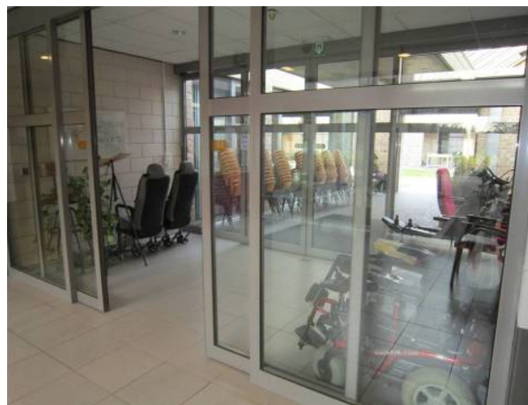
Het voordeel aan een sas met interval tussen de 2 deuren is een tochtscherm. Let wel, passage voor het oog (binnen) opent de deur onnodig. Mané vzw, © Enter vzw
