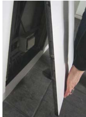
Voetbel, geplaatst ter hoogte van het toilet: Het vlak in de muur kan aangereden worden met de voetsteunen van de rolstoel. Achter de plaat zit een tuimelschakelaar verwerkt. Eigen Thuis vzw, © Enter vzw
