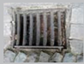
✗ Afvoergoot met gleuven > 2 cm
