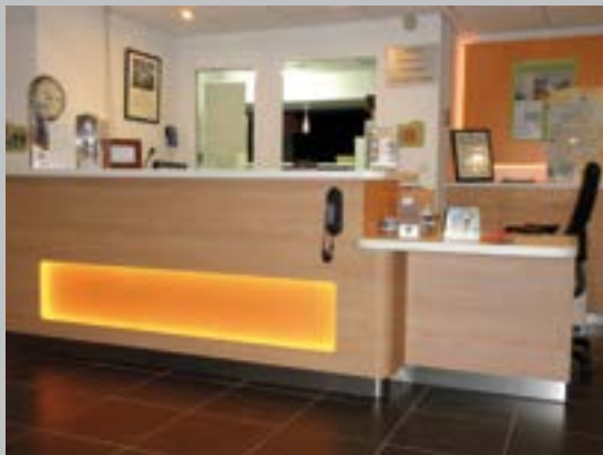
✗ Verlaagd werkblad is niet diep genoeg
