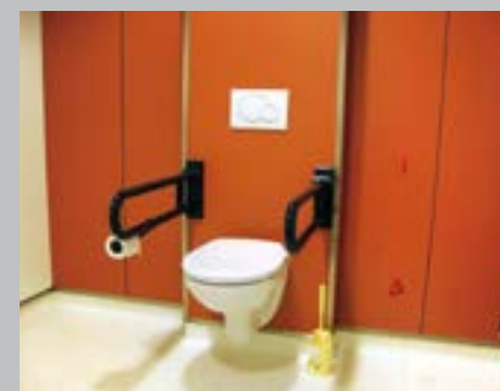
✓ Aangepast toilet met twee transferruimten
