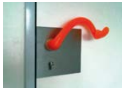
✓ Deurklink in contrasterende kleur en te bedienen met de vuist
