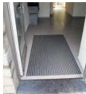
✓ Deurmat ingewerkt in de vloer
