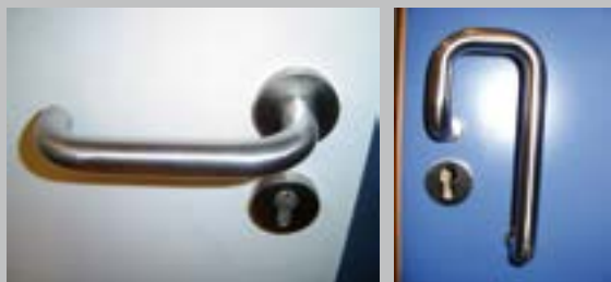
✓ Gemakkelijk vast te grijpen deurklinken in U- of J-vorm
