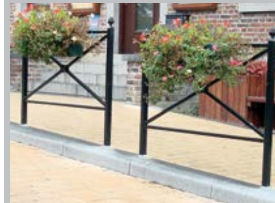
✔ Hek in contrasterende kleur en met conforme hoogte
