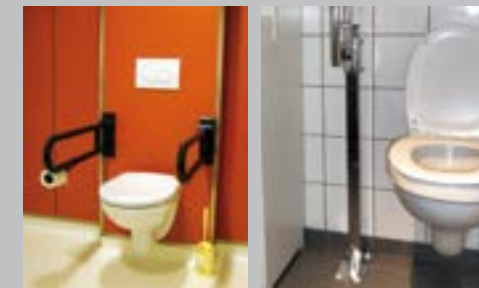
✗ Bevestigingsschoen in de transferzone
