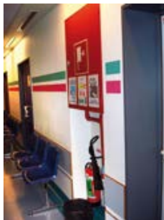
✓ Brandblusapparaat aangebracht in een nis
