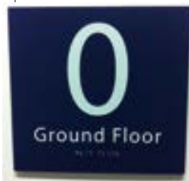
✓ Nummer van de verdieping met identificatie in brailleschrift
