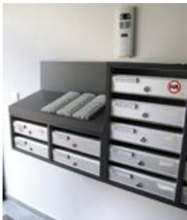
✗ Deurbellen te hoog en te horizontaal aangebracht
