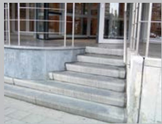
✗ Niet-contrasterende trapneuzen
