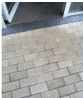
✓ Aaneengesloten en platte straatstenen
