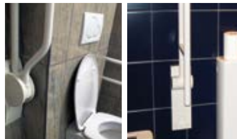
✓ Bevestigingsschoen buiten de transferzone
