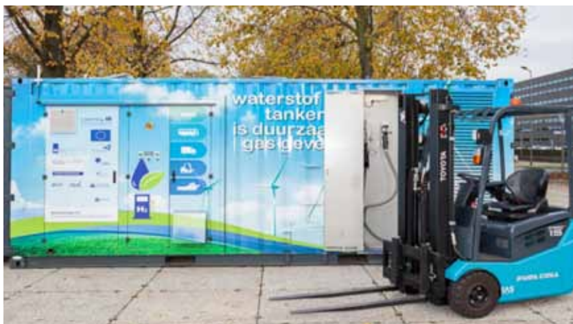
Het mobiele waterstoftankstation in een 20' voet containerbehuizing (bron: WaterstofNet)
