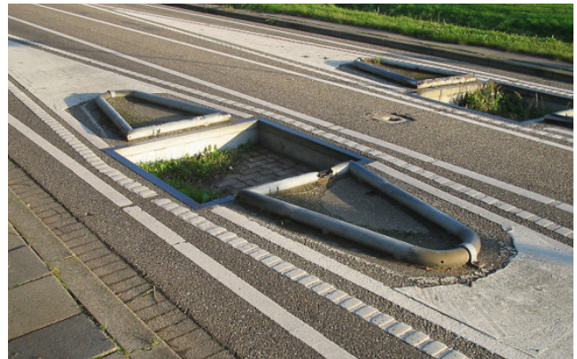
Een bussluis is een aanpassing aan het wegdek waardoor enkel bussen kunnen passeren. Gewone auto's of vrachtwagens kunnen niet passeren. Een bussluis zorgt voor een betere doorstroming van bussen.
