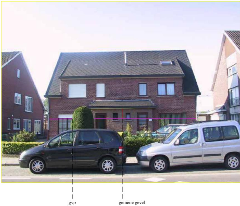
Figuur 5: Deze figuur toont een niet-gematerialiseerde as, ter hoogte van de zwarte stippellijn (gemene gevel), die de constructie opdeelt in twee gespiegelde delen. Deze as komt vermoedelijk overeen met een interne opdeling van het gebouw.
