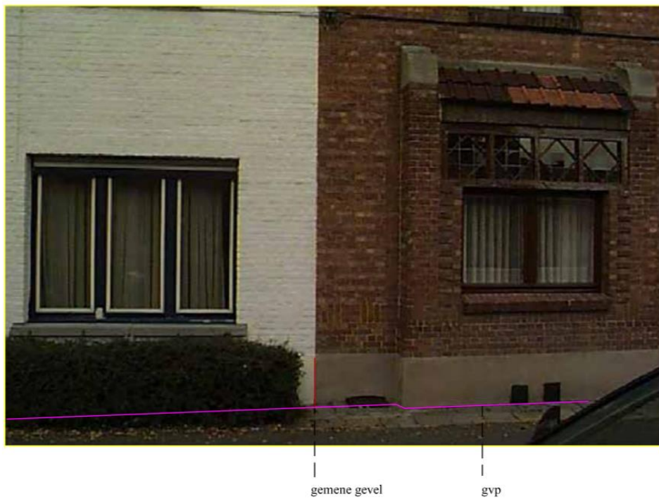
Figuur 6: Deze figuur toont een gematerialiseerde as (kleurverschil), ter hoogte van de zwarte stippellijn (gemene gevel)).
