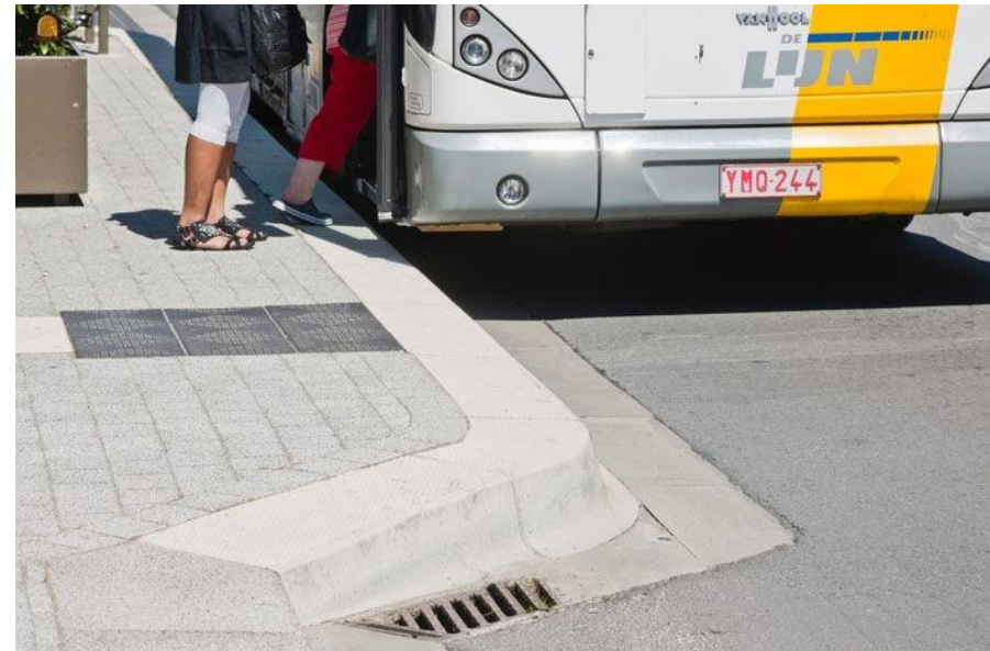
Figuur 5: Een toegankelijke bushalte heeft een aanrijdbare boordsteen en tactiele geleiding
