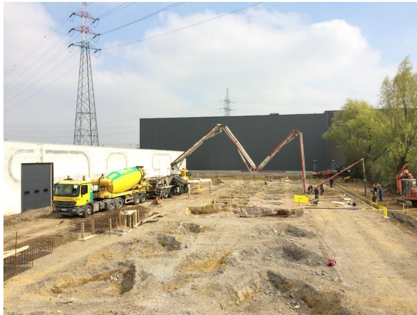
april 2017 - fundering gebouw B
