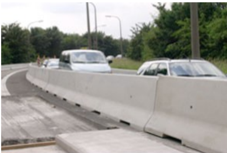
Figuur 11: Deltabloc (prefab) betonnen wegafbakeningselementen (Bron: http://www.omnibeton.be )
