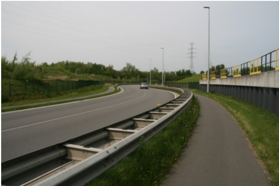
Figuur 12: Metalen afscherpende constructies (Bron: http://fietsbult.wordpress.com/2008/05/31/gent-zelzate-1 )
