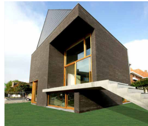
Hulst - nieuwbouw woning
