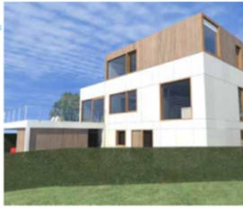
Oudewaarde - verbouwing woning
