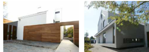
Gent - verbouwing woning Kortrijk - verbouwing woning
