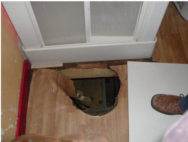
gat in de verdiepingsvloer
