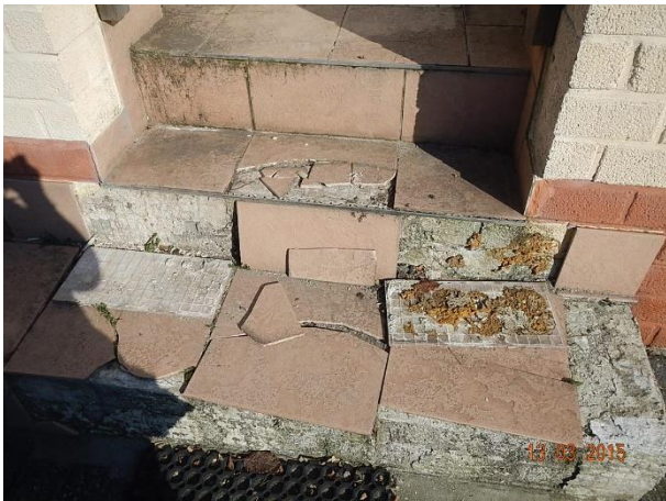
Loskomende en beschadigde tegels bij inkom
