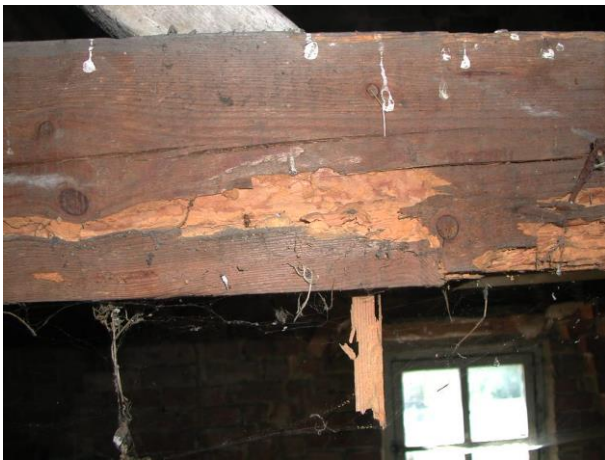
aantasting houten dakspant door insecten
