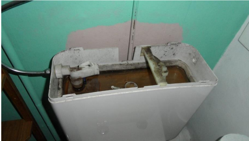
Spoelmechanisme beschadigd
