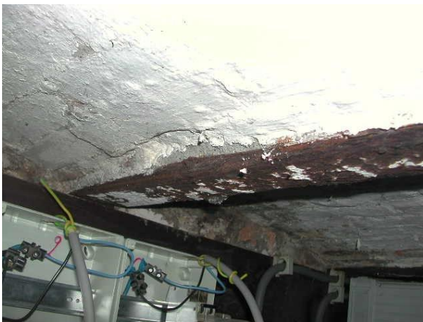
onveilige verbinding van bedrading in kast
