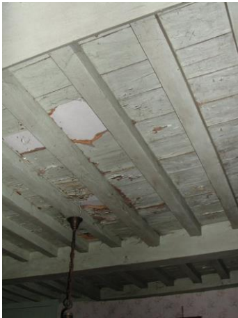
gat in verdiepingsvloer voorlopig gedicht
