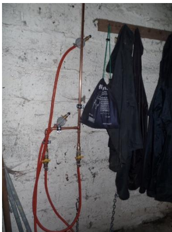
te lange verbinding met gasslangen
