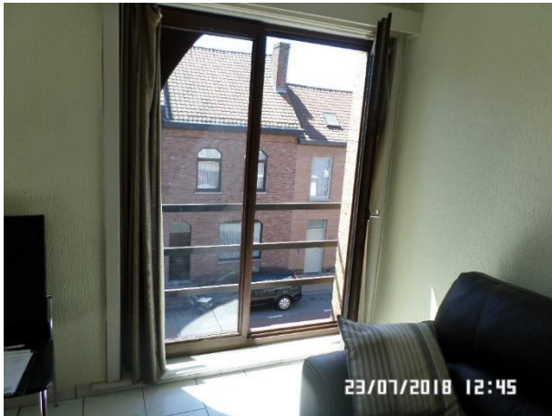
Borstwering te licht, te open en beklimbaar
