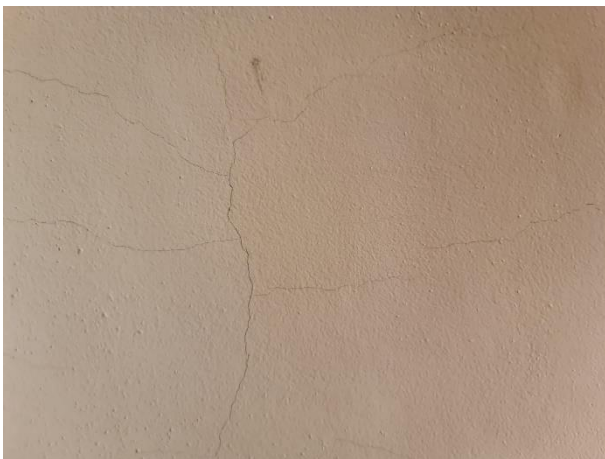
in afwerking buitenmuur
