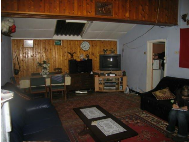
Onvoldoende lichtinval/uitzicht in de leefkamer
