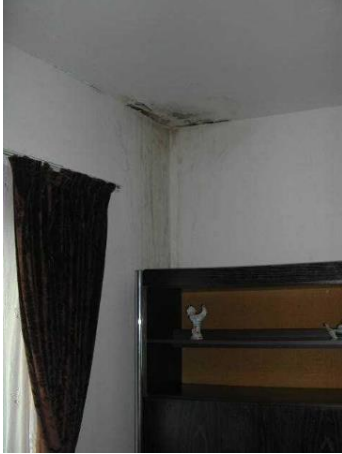
insijpelend vocht met beperkte schimmelvorming
