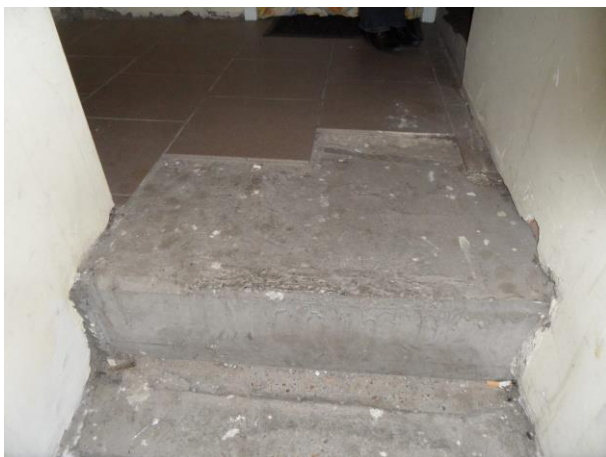
vloertegels en afwerking ontbreken
