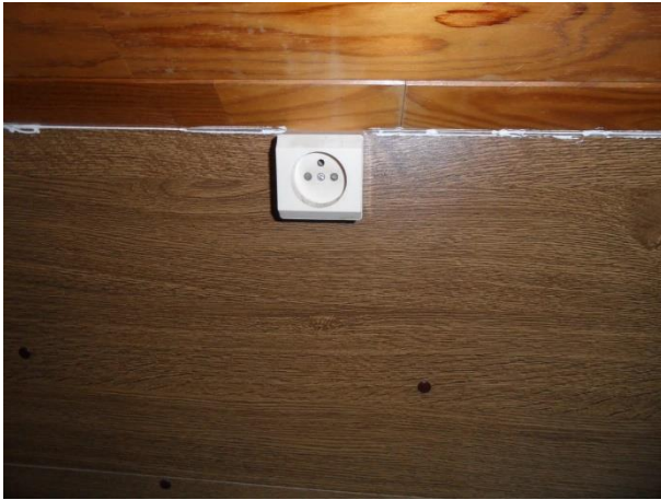
Aardingspen verwijderd uit stopcontact
