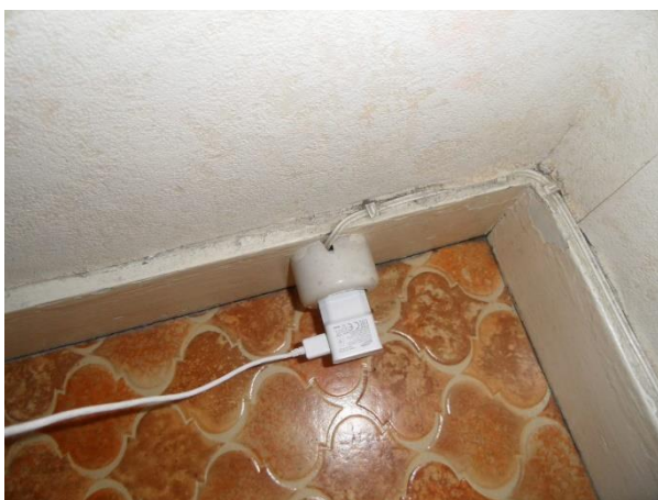
Stopcontact met te lichte bedrading
