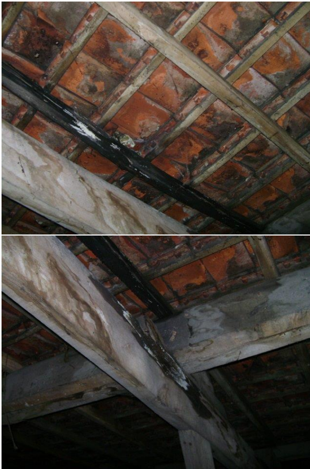
ernstige aantasting houten keper en spant
