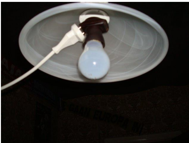
stopcontact in de leefkamer ontbreekt
