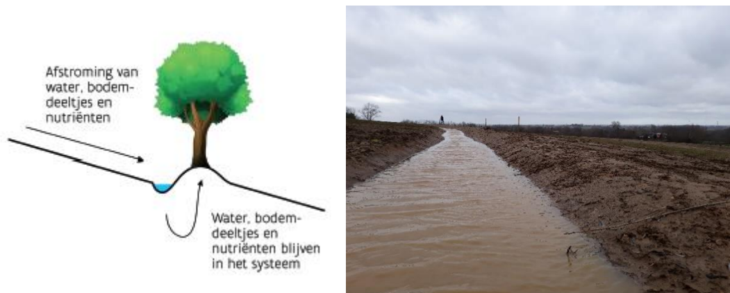
Figuur 1. Links: Werkingsprincipe van een swale of greppel-berm structuur. Rechts: opvang van water, sediment en nutriënten in een pas aangelegde swale in Westouter (Heuvelland).
