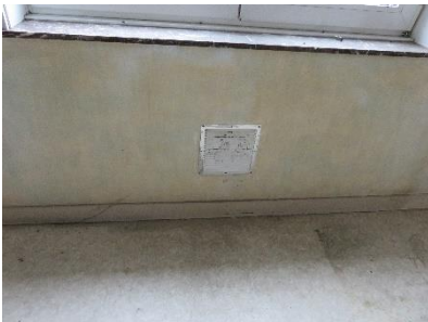
Figuur 23: muurrooster in grote slaapkamer
