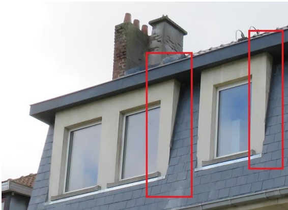
Figuur 26: Verliesoppervlakken van de zijgevels van de dakkapellen
