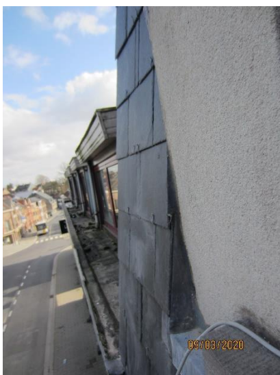
Figuur 34: Mansardedak met leien
