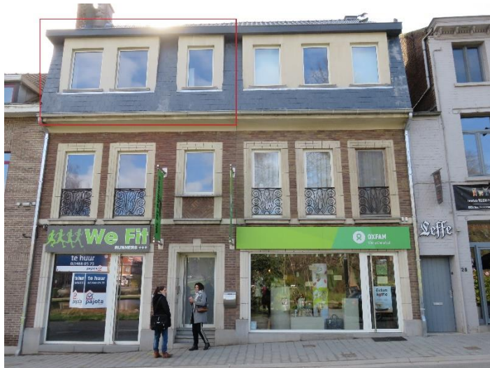
Figuur 15: Het appartement bevindt zich op de 2e verdieping links
