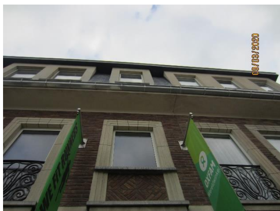
Figuur 37: Uitkragende vloer
