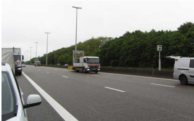
Foto 4: Botsabsorbeers beveiligen de technici die de meetinstallaties plaatsen
