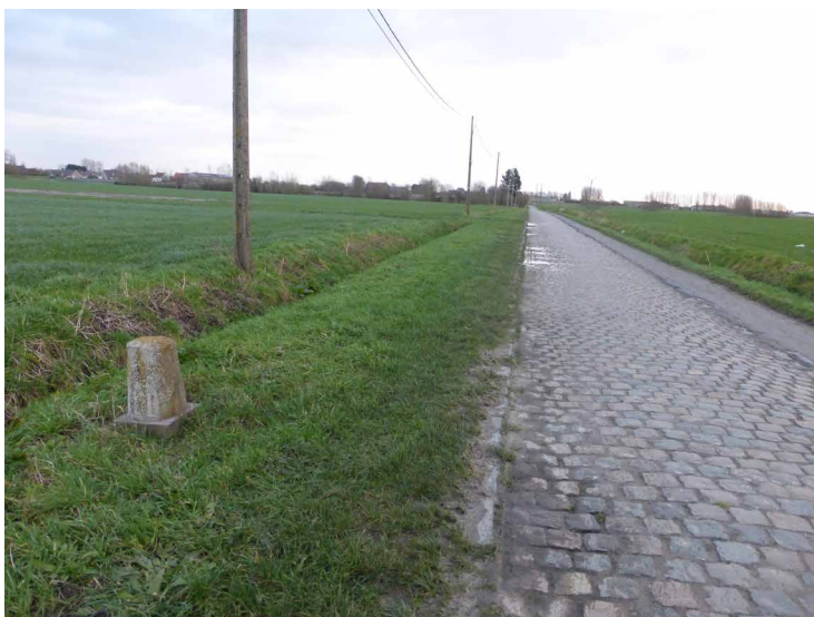
FIG 179 Kilometerpaal langs de kasseiweg Vladslostraat in Bovekerke (foto: Inge Verdurmen).
