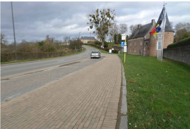
FIG 144 Voetpad bij Alden Biesen met hergebruik van oorspronkelijke boordstenen in combinatie met nieuwe klinkers (foto: Myriam Van Den Broeck).
