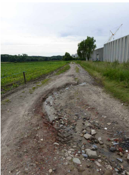
FIG 115 Geulvorming door watererosie op half verharde landweg in Asse (foto: Inge Verdurmen).
