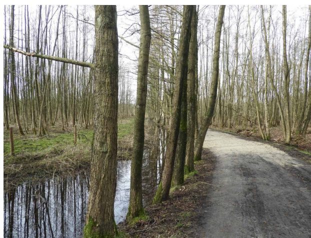
FIG 147 Putten in de weg gevuld met gebiedseigen zand in het bos De Stropers (foto: Nele Vanmaele).
