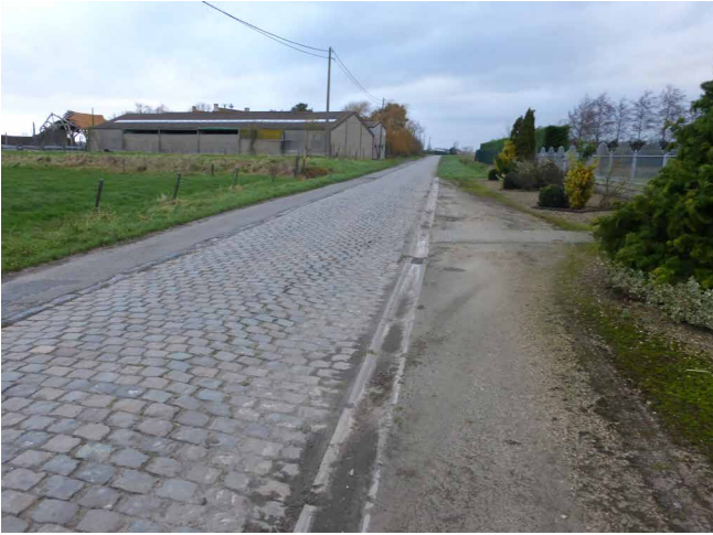
FIG 98 Verbreding van de weg ter hoogte van een inrit langs de Vladslostraat in Bovekerke (foto: Inge Verdurmen).
