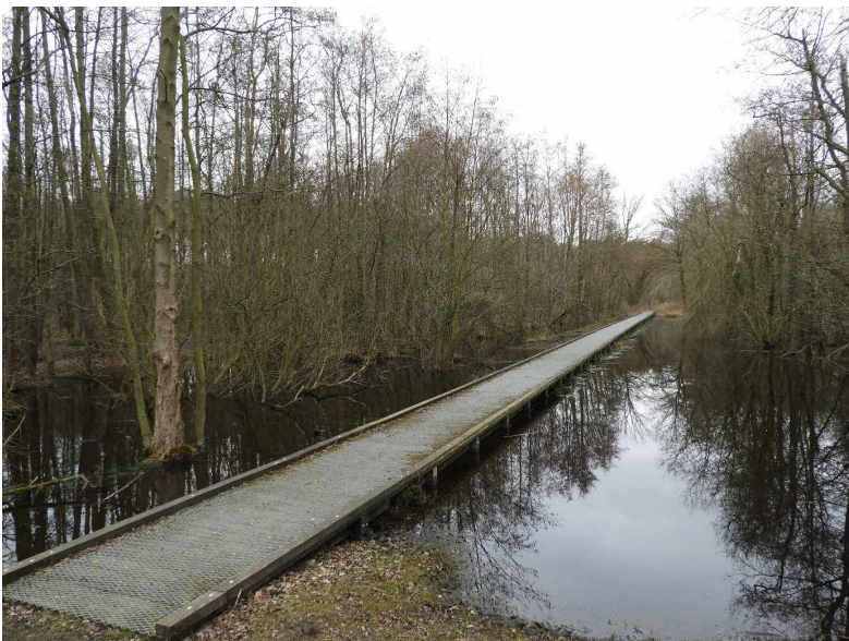
FIG 120 Knuppelpad met antisliprooster en stootboord in het bos De Stropers (foto: Nele Vanmaele).
