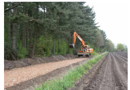
FIG 110 Aanleg fundering onder zandweg in de Brechtse Heide (foto: Dirk Artois).
