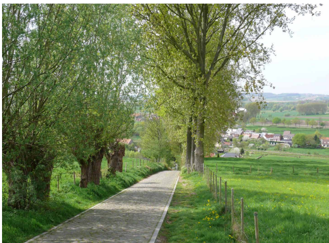
FIG 146 De kasseiweg Steengat of 'Koppenberg' in Oudenaarde werd herlegd met de oorspronkelijke kasseien (foto: Geert Van der Linden).
