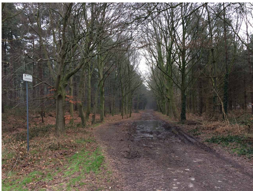
FIG 133 Spoorvorming en stagnerend water in de Antwerpse Heirweg in Assenede (foto: Virginie Peeters).
