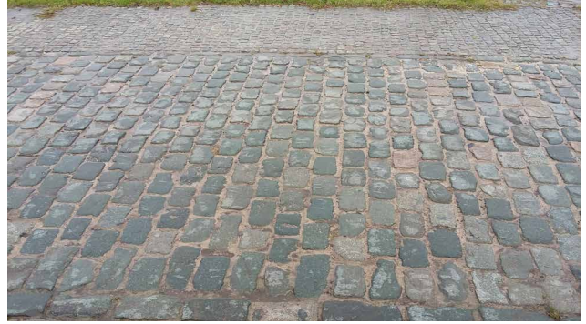
FIG 118 Voorbeeld van een water doorlatende voeg bij de kasseiweg Varentstraat in Anzegem (foto: Koert David).
