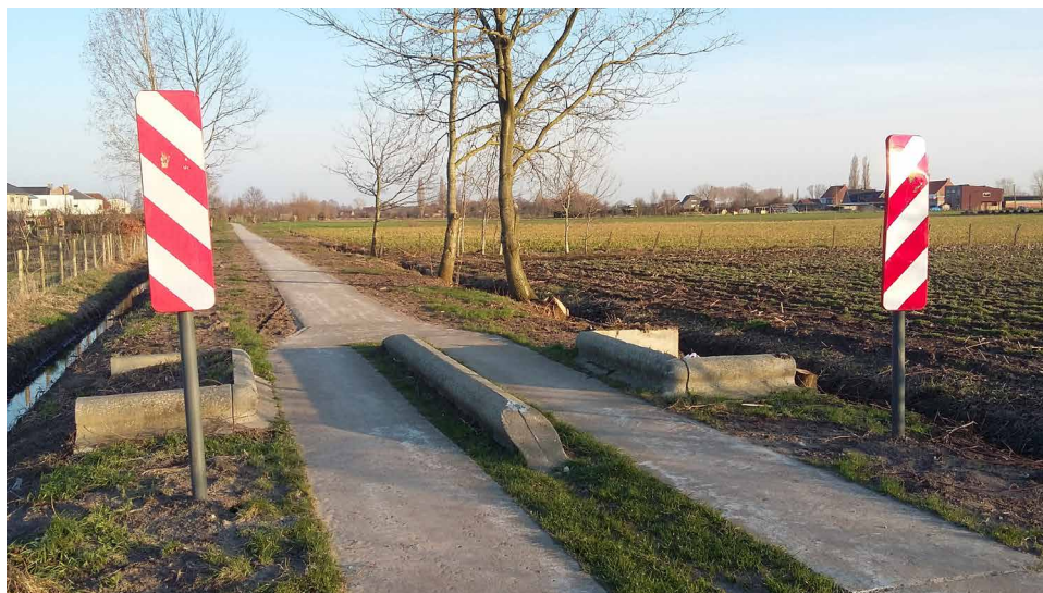
FIG 139 Tractorsluis langs de Processtraat in Petegem (foto: Nele Vanmaele)
