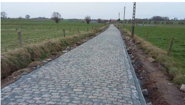
FIG 131 Heraanleg Lookhuisstraat in Anzegem met hergebruik van de oorspronkelijke kasseien na uitsortering (foto: Koert David).
