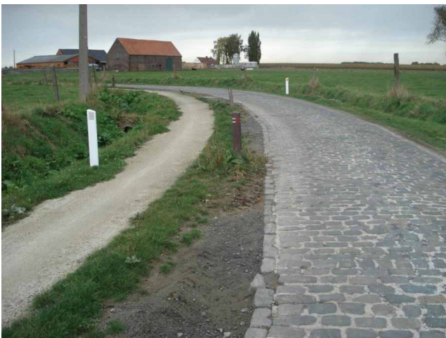
FIG 129 Half verharde comfortstrook voor fietsers langs De Varent in Kerkhove (foto: Geert Van der Linden).
