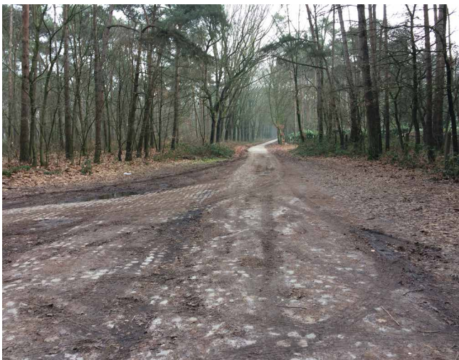
FIG 96 Verbreding van de rijweg in de bochten van de Antwerpse Heirweg in Assenede (foto: Virginie Peeters).
