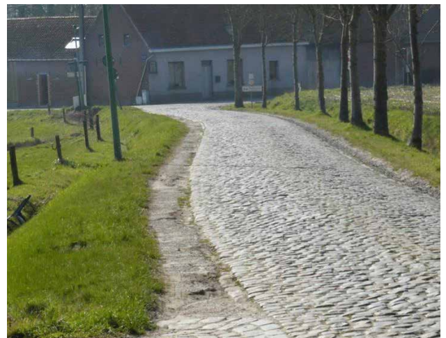
FIG 138 Half verharde uitwijkstrook bij kasseiweg Paddestraat in Zottegem (foto: Geert Van der linden).
