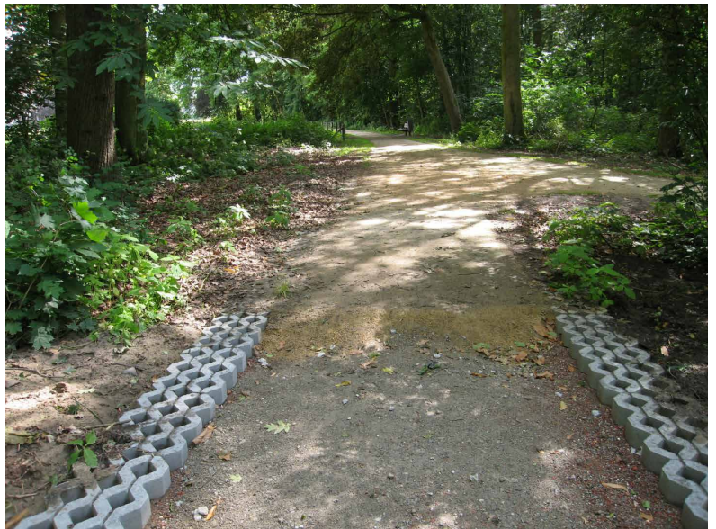
FIG 116 Heraanleg wandelpad met gestabiliseerde halfverharding om toegankelijkheid te verbeteren in kasteel Wallemote in Izegem (foto: Koen Himpe).
