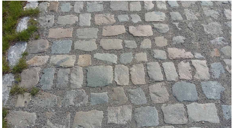
FIG 143 Fouten in het legverband in de recent heraangelegde Lookhuisstraat in Ichtegem (foto: Koert David).
