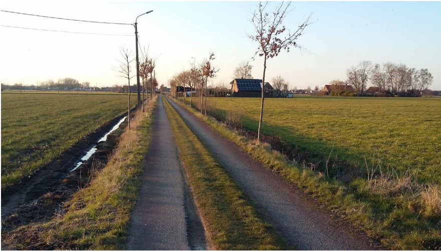
FIG 127 Heraanleg met twee half verharde sporen van de Brandstraat in Machelen (foto: Nele Vanmaele).
