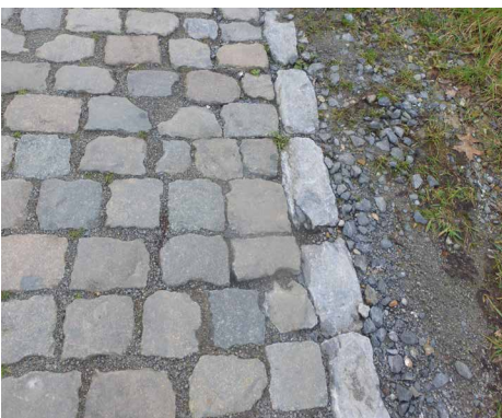
FIG 145A-145B Gebruik van nieuwe (foto links) en originele (foto rechts) veldborduren bij de heraanleg van de Lookhuisstraat in Ichtegem (foto's: Inge Verdurmen).
