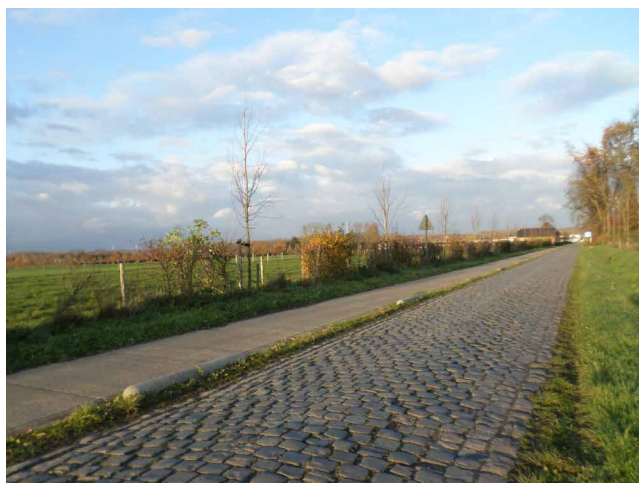
FIG 125 Comfortstrook aangelegd naast de bestaande kasseiweg Printhagendreef in Kortesseem (foto: Myriam Van Den Broeck).
