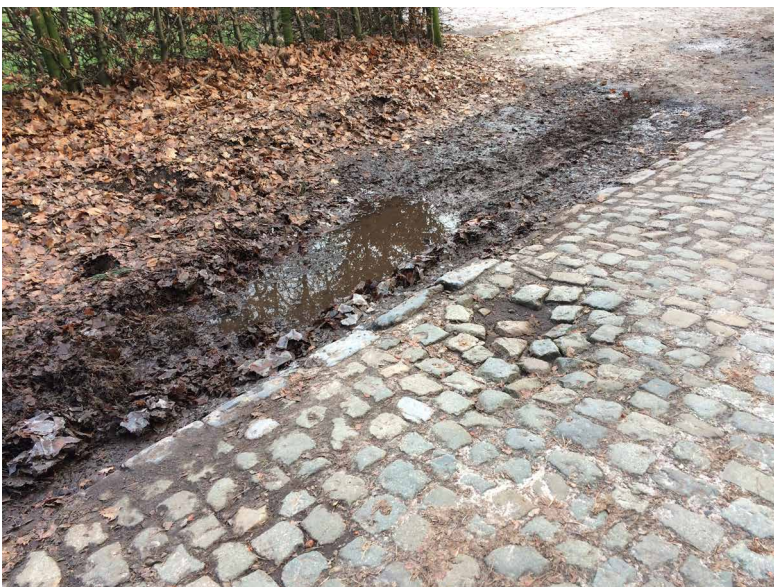
FIG 85 Druk autoverkeer veroorzaakt frequent berijden van de onverharde berm langs de Antwerpse Heirweg in Assenede (foto: Virginie Peeters).
