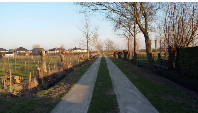
FIG 137 Tweesporenweg in de Processtraat in Petegem (foto: Nele Vanmaele).
