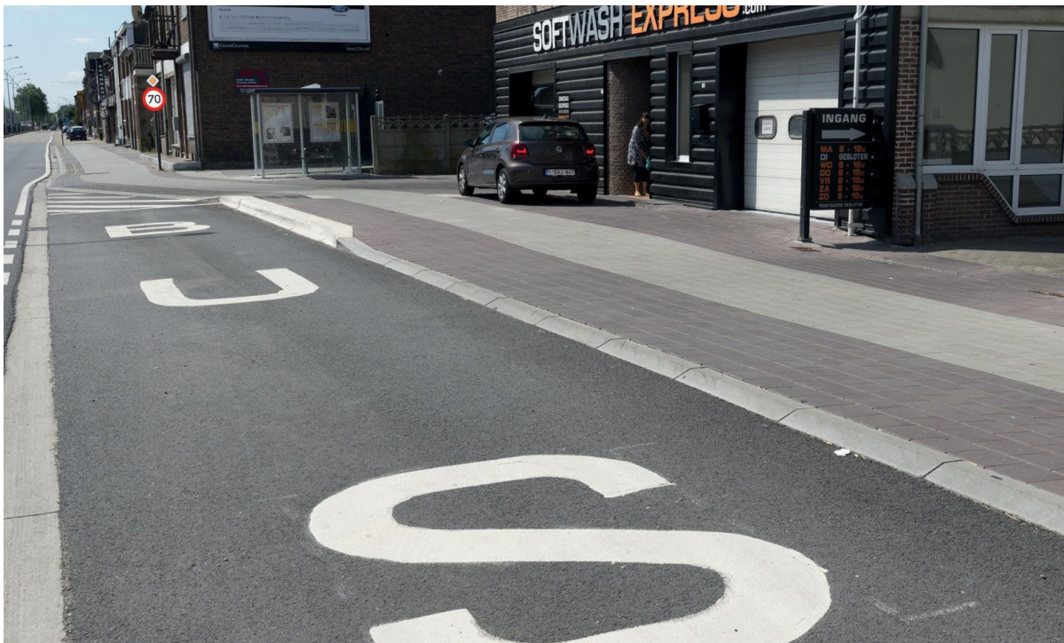
Verhoogd busperron aangepast aan de plaatselijk toegangen tot aanpalende percelen.
