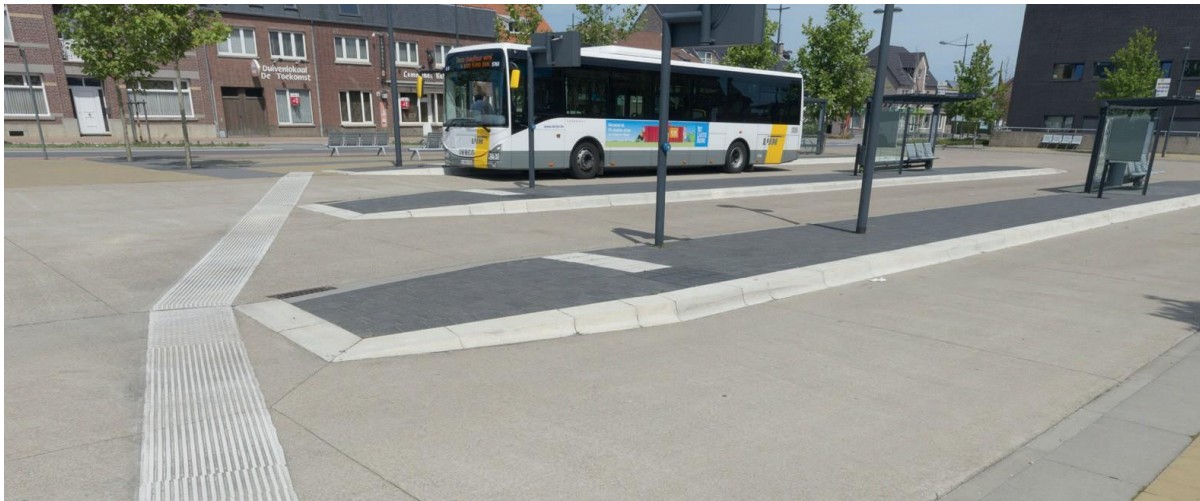
Busstation Riemst: een perron bereikbaar met hellend vlak.
